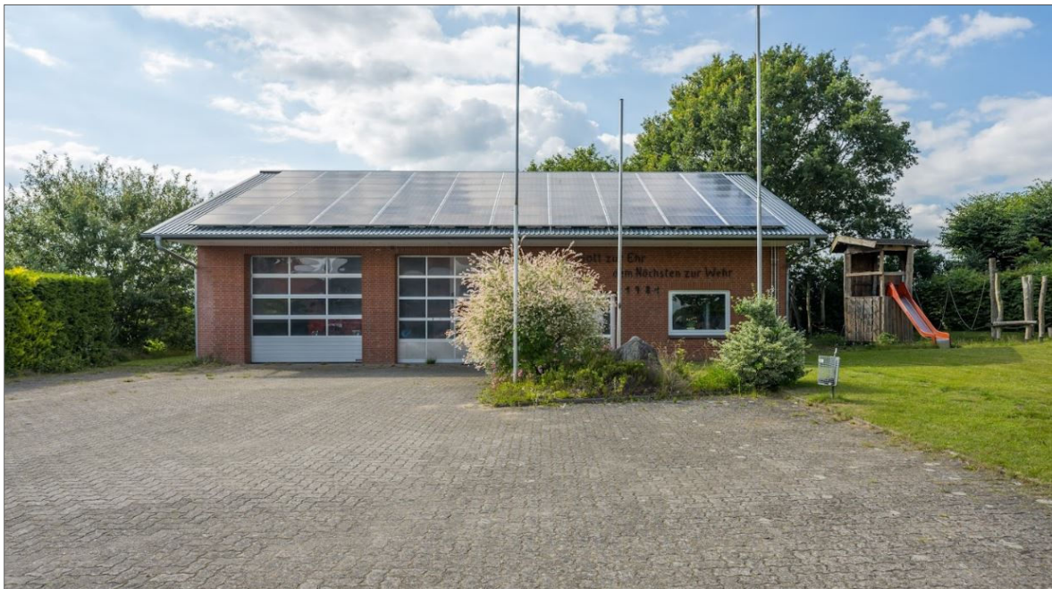
Abb.1. 2: Gebäude Freiwillige Feuerwehr Negenharrie (Stand Mai 2022)
