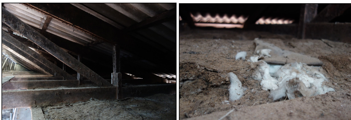
Abbildung 6 & 7: abgehängte und gedämmte Decke über den ehemaligen Liegeplätzen (Foto: ALSE 16.12.2020)
