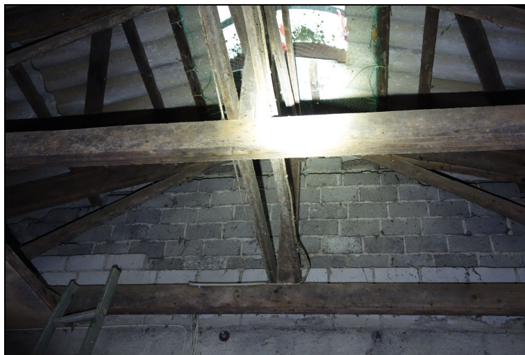
Abbildung 5: transparente Wellplatten auf dem Dach mit darunter hängendem Netz (Foto: ALSE 21.01.2021)
