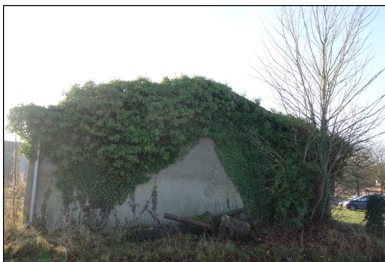
Abbildung 8: Nordansicht des Stallgebäudes (Foto: ALSE 16.12.2020)
