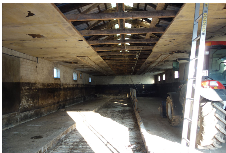
Abbildung 4: Innenansicht des Stallgebäudes (Blick von Süden) (Foto: ALSE 16.12.2020)
