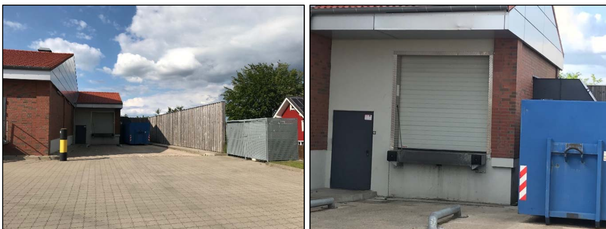
Bild 3.2: Discountmarkt, Anlieferzone mit Lärmschutzwand
