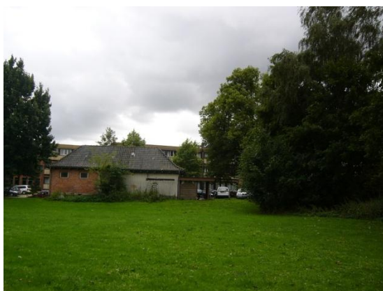
Blick von Westen auf Fl.st. 91/15 zum Garagengebäude, vor dem eine Stellplatzfläche neu entstehen soll
