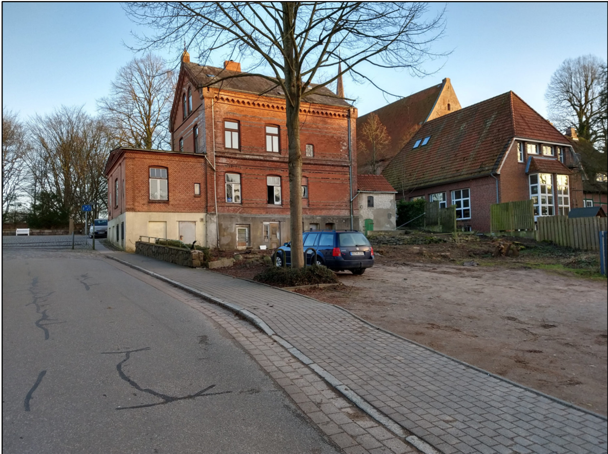
Abbildung 4: Bestandsgebäude mit gehölzfreiem Grundstück
