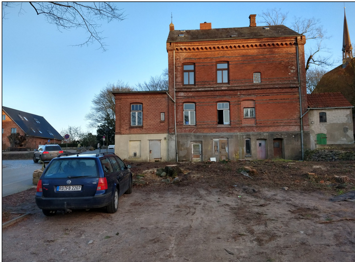
Abbildung 3: Bestandsgebäude am Lindenplatz 14, Rückwärtige Ansicht
