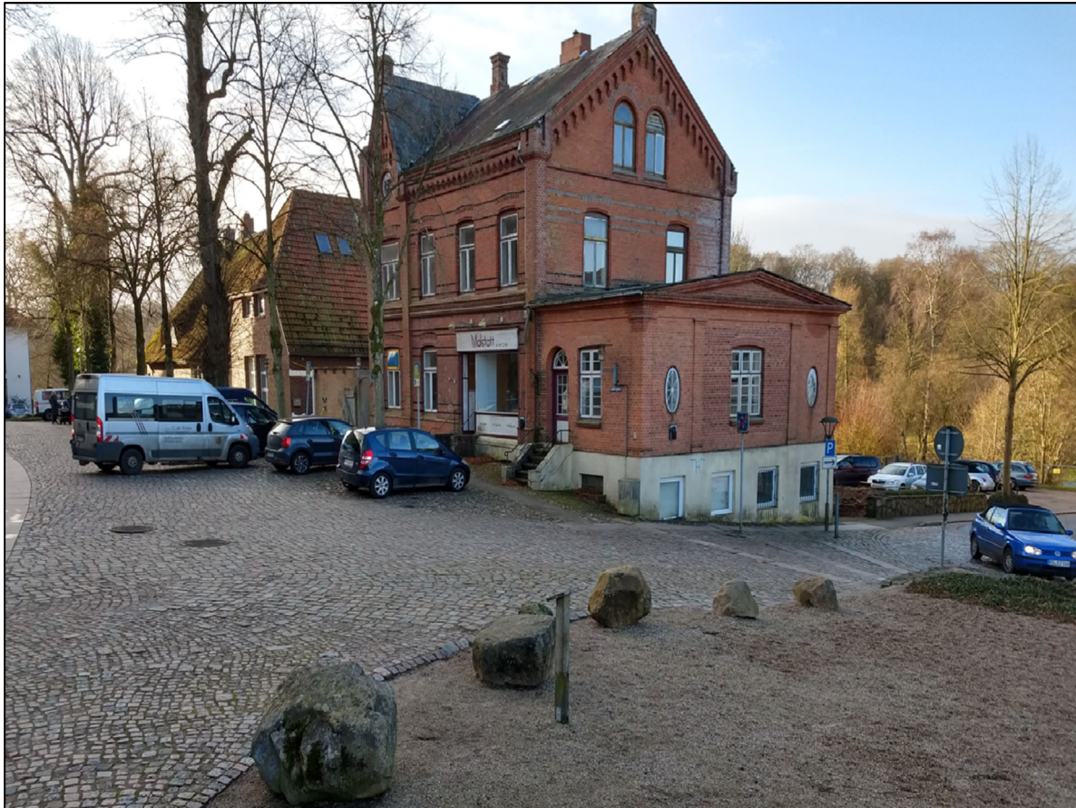
Abbildung 2: Bestandsgebäude am Lindenplatz 14, Vorderansicht
