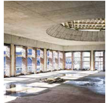
Bauphase Sitzungssaal Dach
