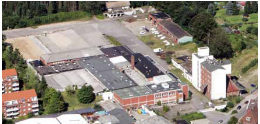
Vor dem Abriss
